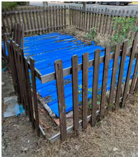
图 3-1 废水预处理设施现场图片
